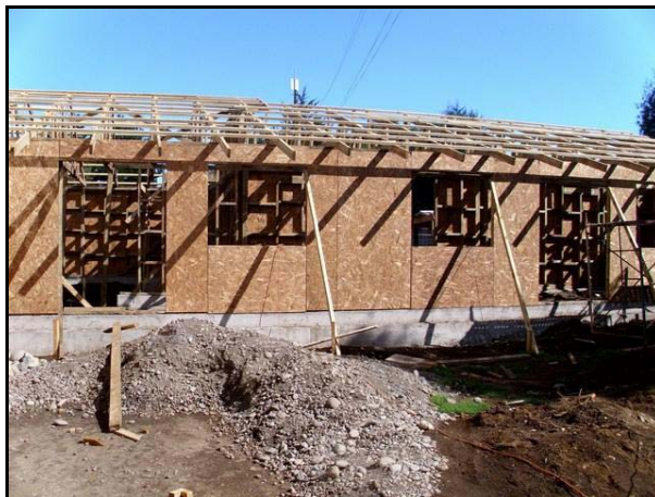
Construcción de Salas de Clases
