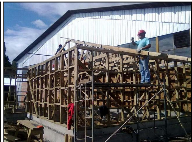
Construcción Patio cubierto de Pre básica
