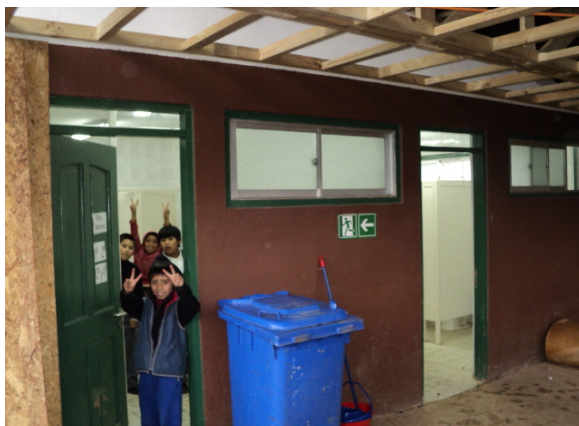
Reposición Baños escuela Vega Redonda
