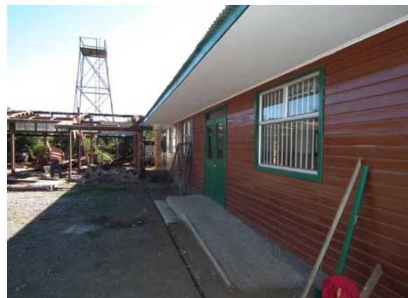
Construcción 3 salas escuela Vega Redonda
