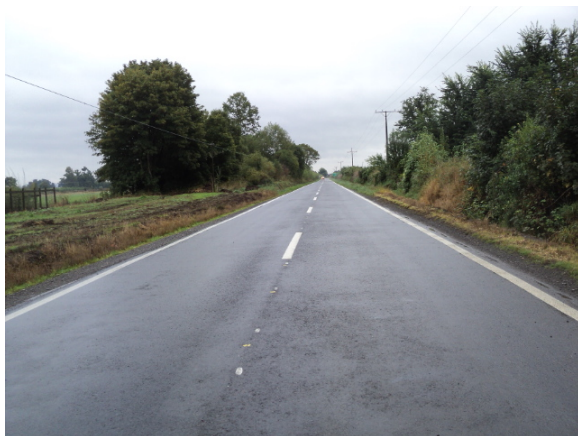
Reparación sector Arquenco
