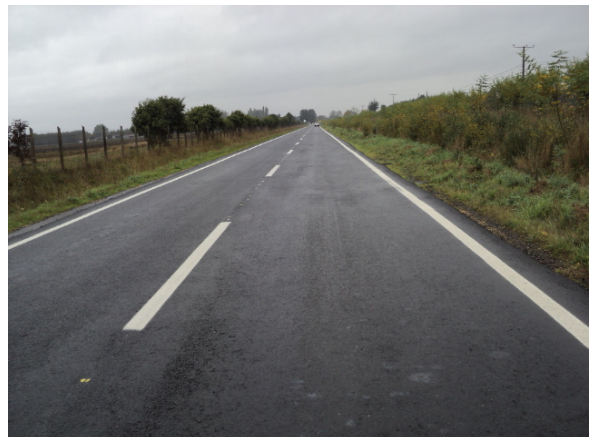
Reparación Sector Carillanca
