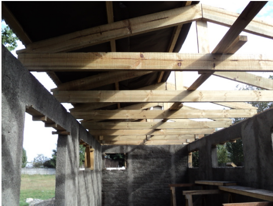
Construcción camarines de 41 m 2
