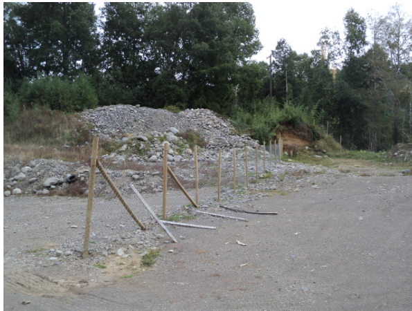
Se habilitó el terreno con cercos, confección de chimeneas y bodega para operadores
